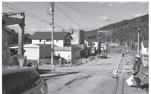
▲あけぼの町道改修工事 工期は12月10日まで。今しばらくご不便をおかけしますが、冬には段差も解消され、安心して走行できるようになります。
