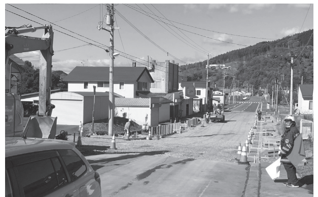
▲あけぼの町道改修工事 工期は12月10日まで。今しばらくご不便をおかけしますが、冬には段差も解消され、安心して走行できるようになります。
