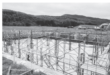
現在建設中の新浄水場
