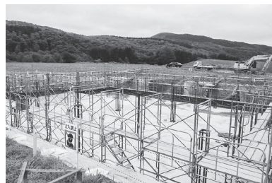
現在建設中の新浄水場
