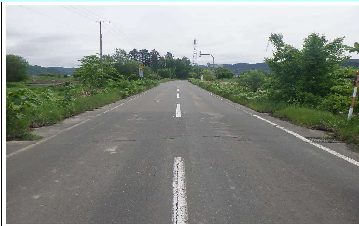
施 工 前 （写真提供：北海道 オホーツク総合振興局 網走建設管理部）
