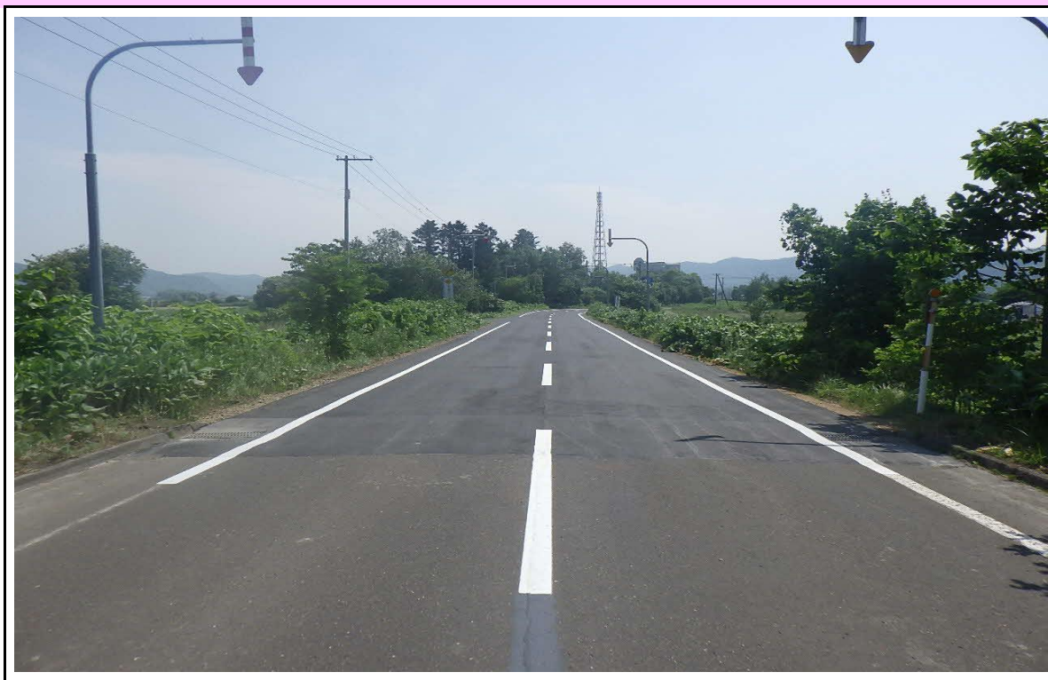
完 成 （写真提供：北海道 オホーツク総合振興局 網走建設管理部）
