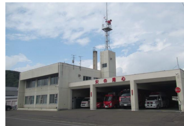
消防庁舎外観
