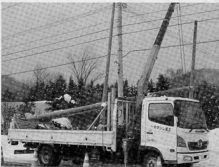
光ケーブル工事
