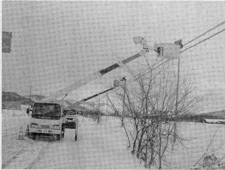
光ケーブル工事
