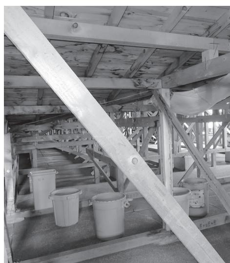
老朽化著しい町立病院、小屋裏の雨漏りをバケツで受けている
