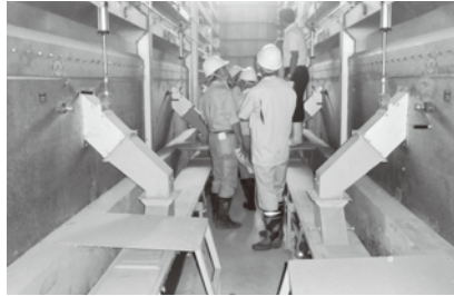
雄鎮内麦乾施設
