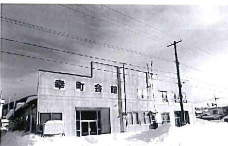
老朽化が著しい幸町会館
