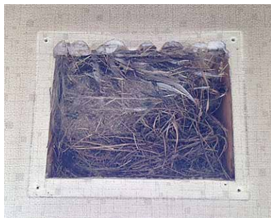
▲「換気口につくられていた鳥の巣」
