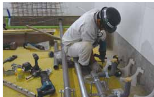
店内では急ピッチで作業が行われています
